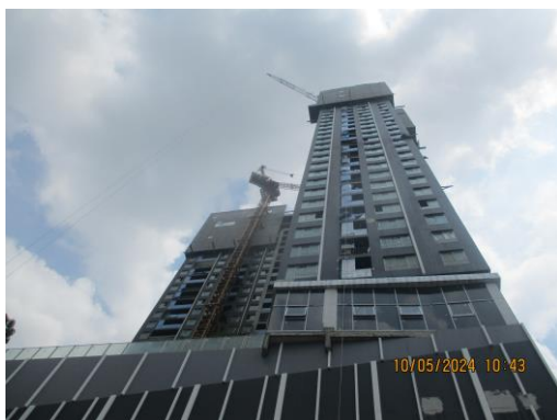
รูปที่ 7 ผนังแผ่นคอนกรีตสำเร็จรูป (Precast)
