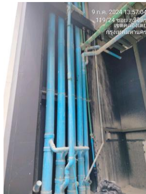
รูปที่ 6 ท่อระบายน้ำภายในพื้นที่โครงการ
