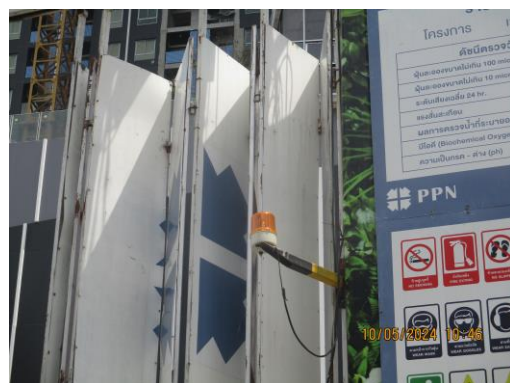
รูปที่ 19 ไฟกระพริบ บริเวณทางเข้า-ออกรถบรรทุกก่อสร้าง
