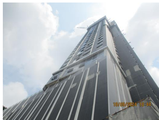
รูปที่ 7 ผนังแผ่นคอนกรีตสำเร็จรูป (Precast)
